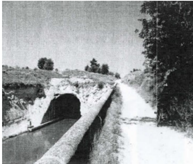
tunnel de Malpas
